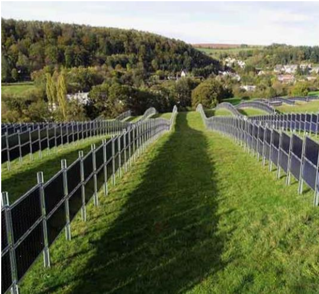
Abbildung 6: Foto einer bifacialen Freiflächenphotovoltaikanlage, Next2sun
